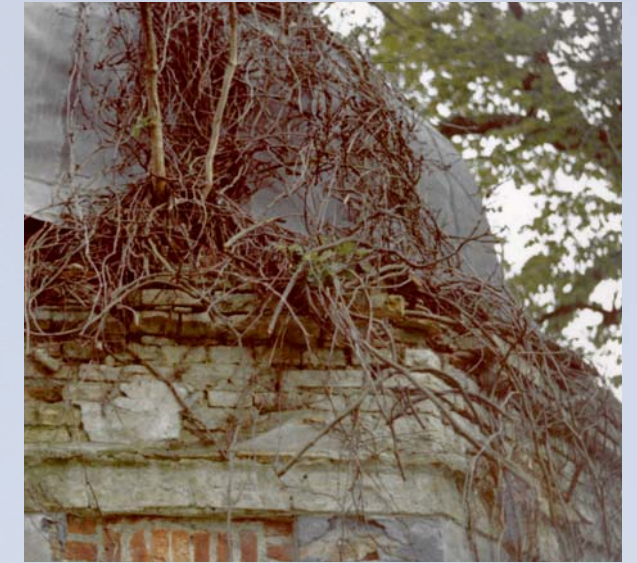
Toppen af tårnet er delvist befriet for vinen og forfaldet er skræmmende: Spiret er sunket sammen og gesimsen er faldet ned. Foto Riff Andersen 1972.
