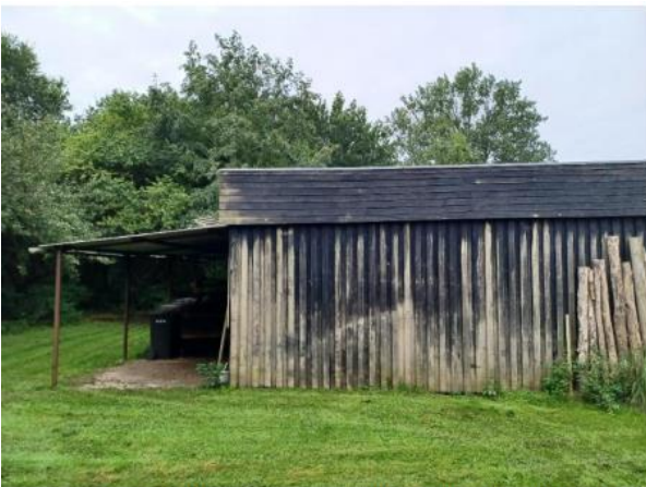
Foto fra Miljøstyrelsens besigtigelse den 13. september 2023. Maskinhuset set fra nord.
