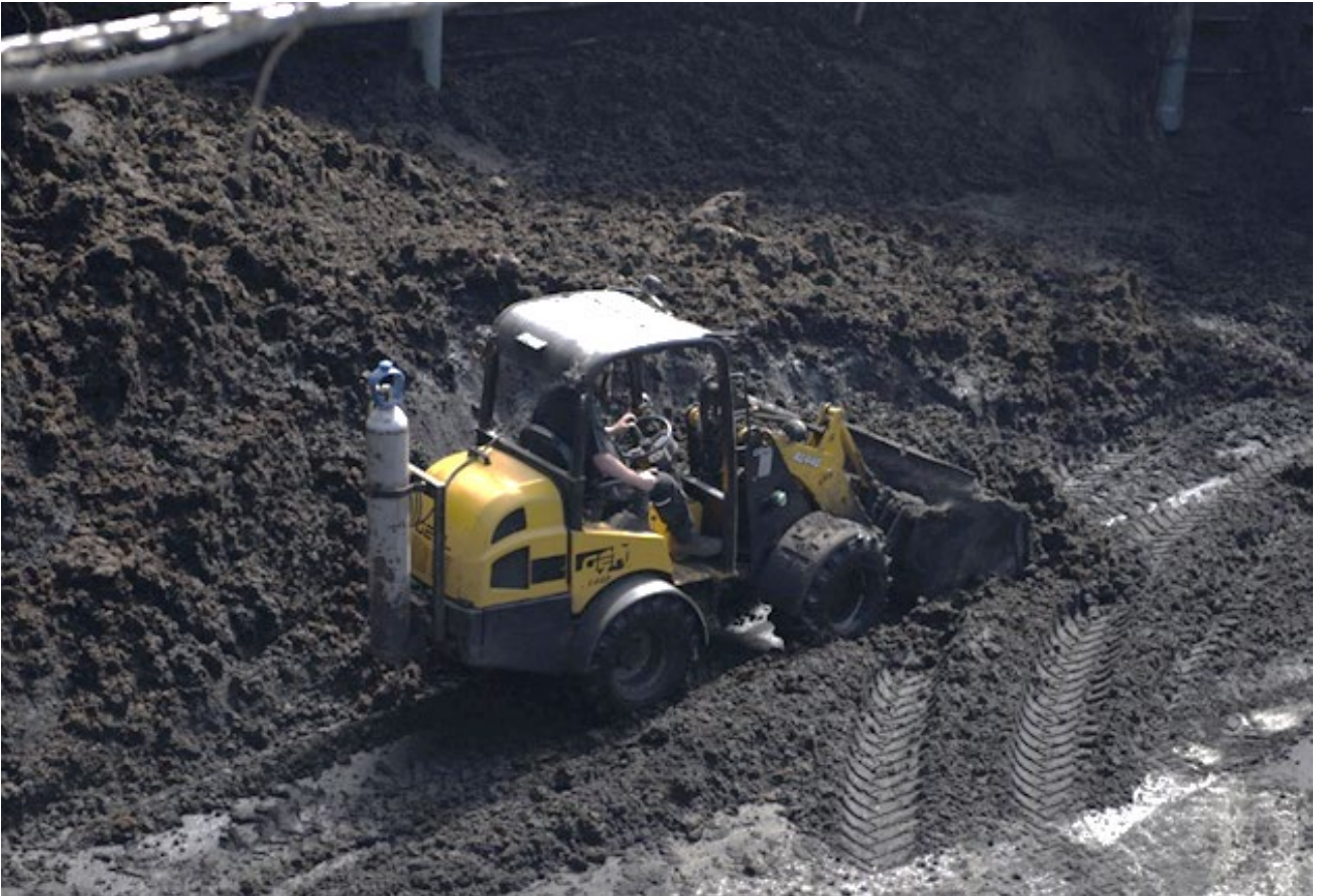
Figur 13-2: Billede der viser en del af processen med oprensning og kontrol af tank.
