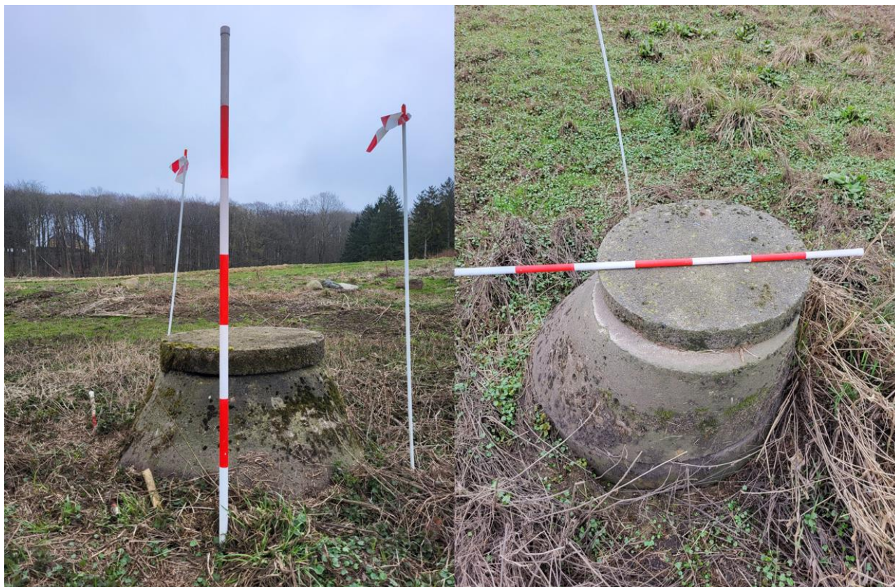
Billede 3.2.1-2: Brøndene 3-9 er alle af ovenstående type "samle-/gennemløbsbrønd med kegleformet top".
