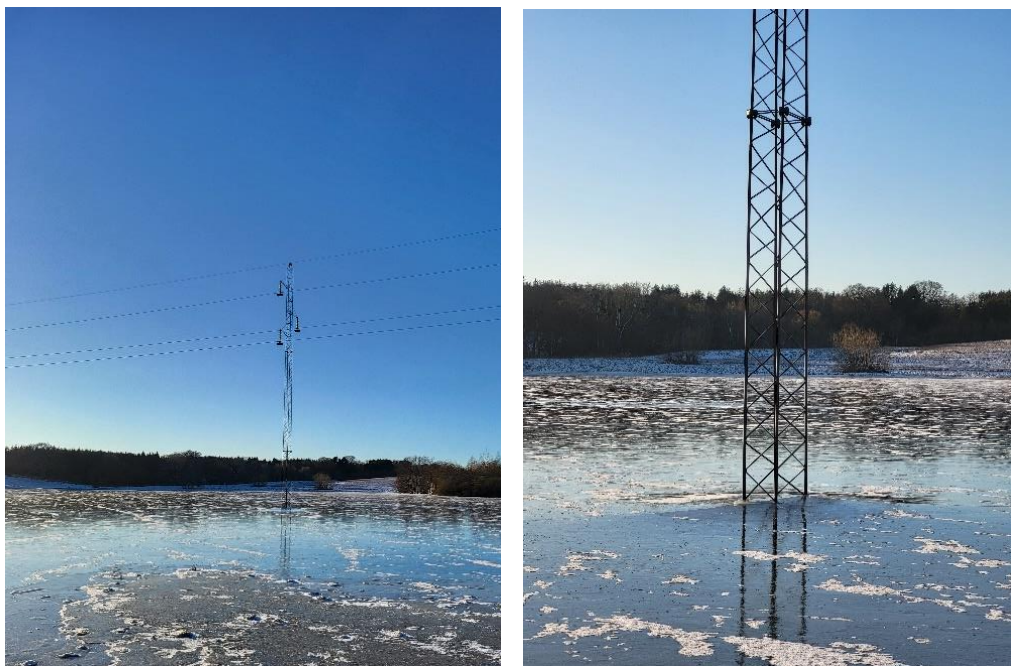
Figur 2.4.2-2.4.3: billedserie af elmast der står under vand (isdække), billederne er taget 8. januar 2024. Det fremgår af billederne, at der ikke er etableret nogle tilkørselsmuligheder til masten.
