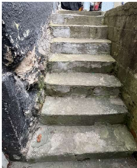
Foto 4: Kældertrappe og kældervæg
