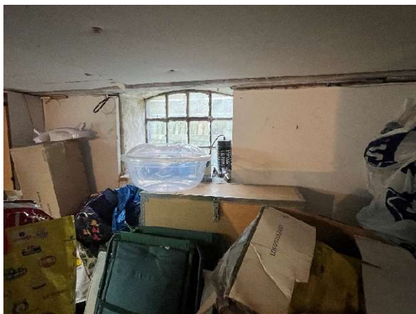
Foto 1: Kælderydervæg og støbejernsvindue
