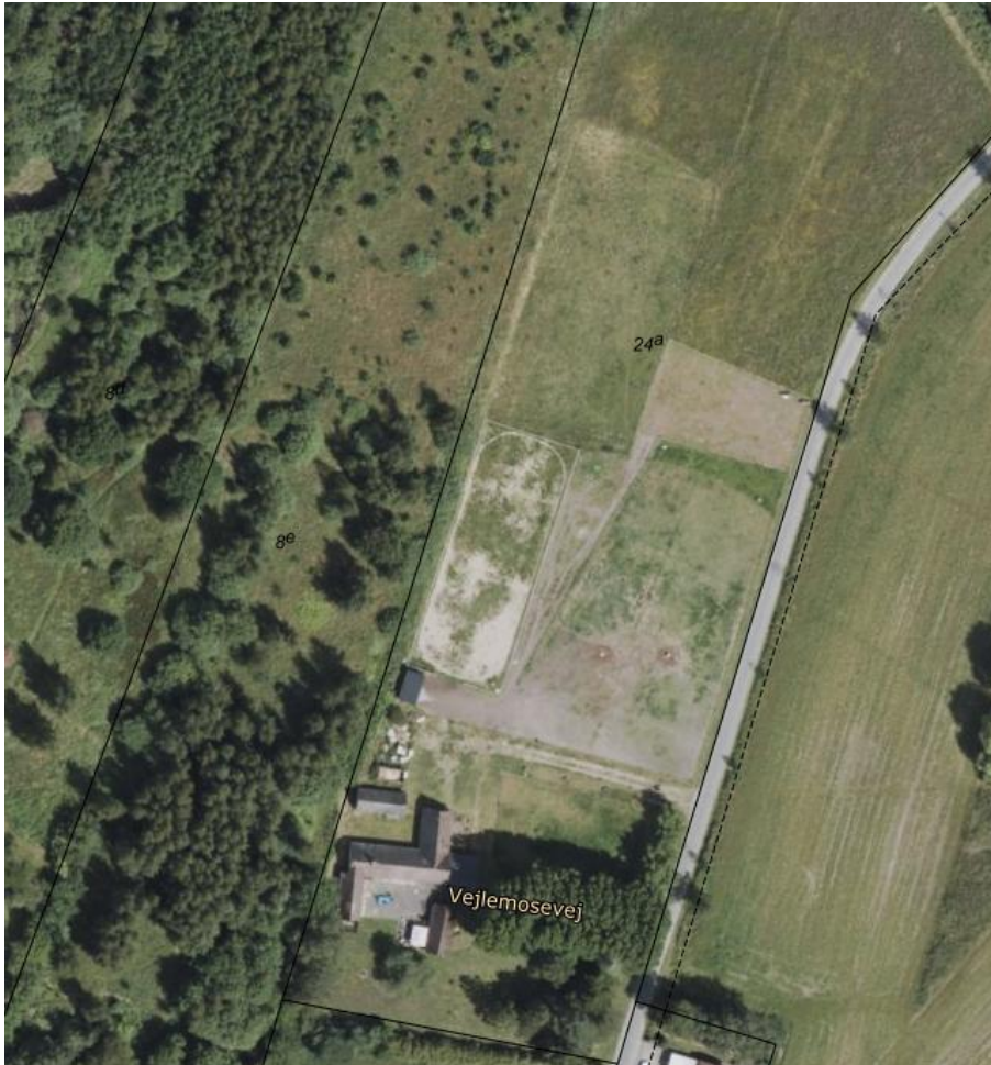
Vejlemosevej 11, 4160 Herlufmagle. Læskuret og ridebanen ligger ikke i nærheden af nabobebyggelse. Luftfoto 2024.
