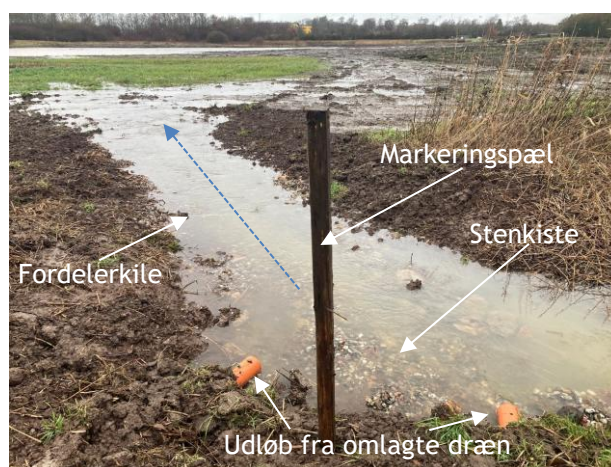
Figur 3-8: Eksempel på drænledninger omlagt til udløb i stenkiste med fordelerkile (på billedet er den dog noget smal). Afstrømningsretningen er angivet med stiptet blå pil.
