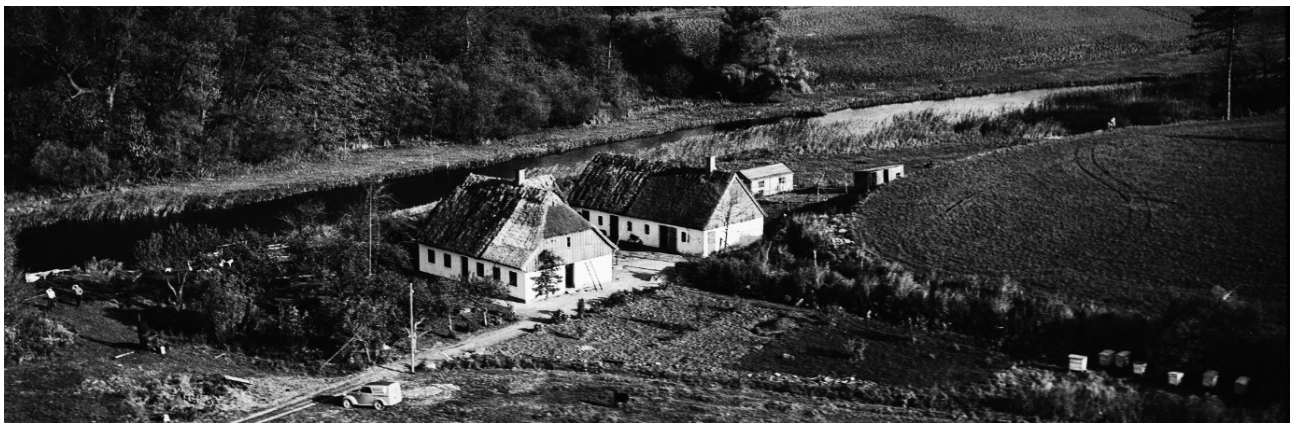
Skråfoto 1950. I forgrunden til venstre ses en plads mellem adgangsvejen og Suså. På modsatte side af vejen, ses det flade delta mod syd tydeligt – her anvendes det til have. Til venstre, mod øst, bag længekomplekset ses to tidligere mindre bygninger.
