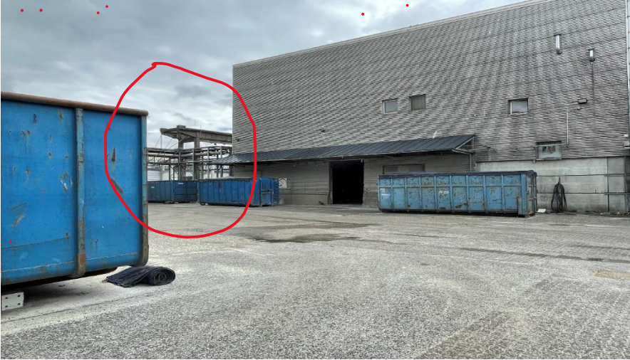
Kranbroen set fra sydvest. Del som ønskes nedrevet er markeret med rød cirkel.
