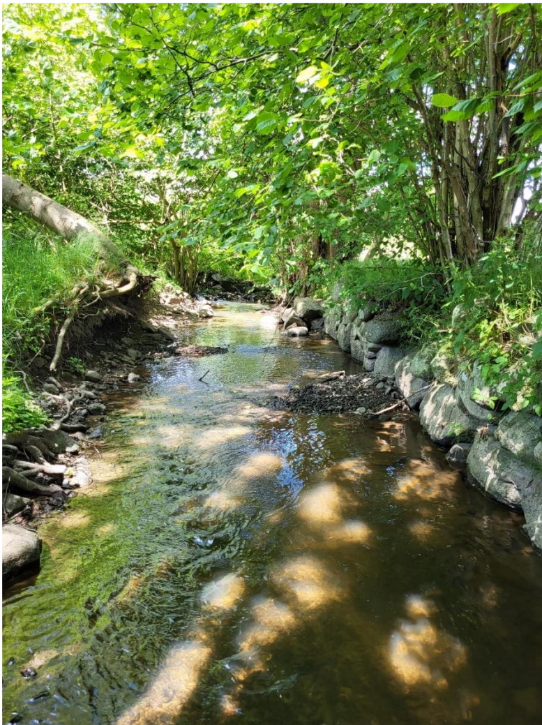
Billede 5.2.2: Der ses det regulerede og kanaliserede vandløb i sin tydeligste form på delstrækning 2 (juni 2024).
