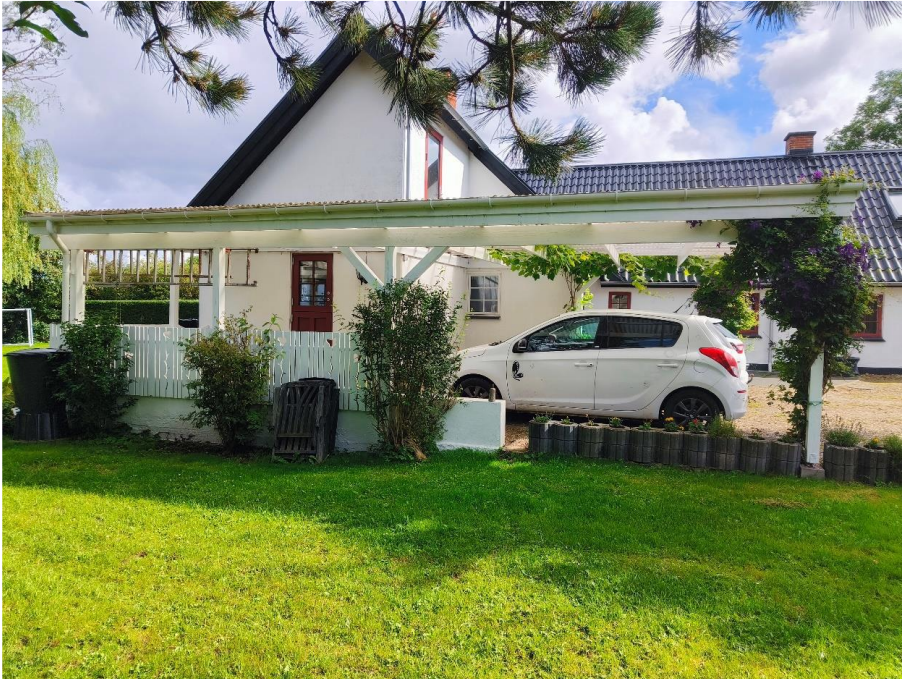
Figur 6: Foto af carporten set fra nord. Fra ansøgningsmaterialet.
