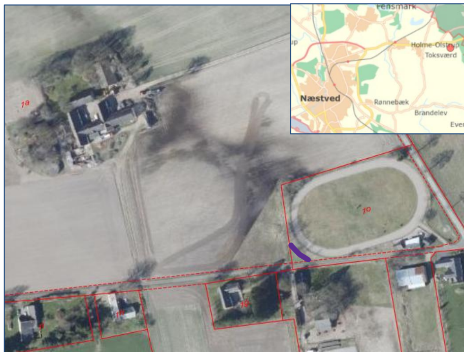
Kort 1: Luftfoto 2025 visende matr.nr. 1o og 1a begge Boserup by, Toksværd, som er omfattet af reguleringsprojektet. Den eksisterende defekte rørledning er markeret med lilla.
