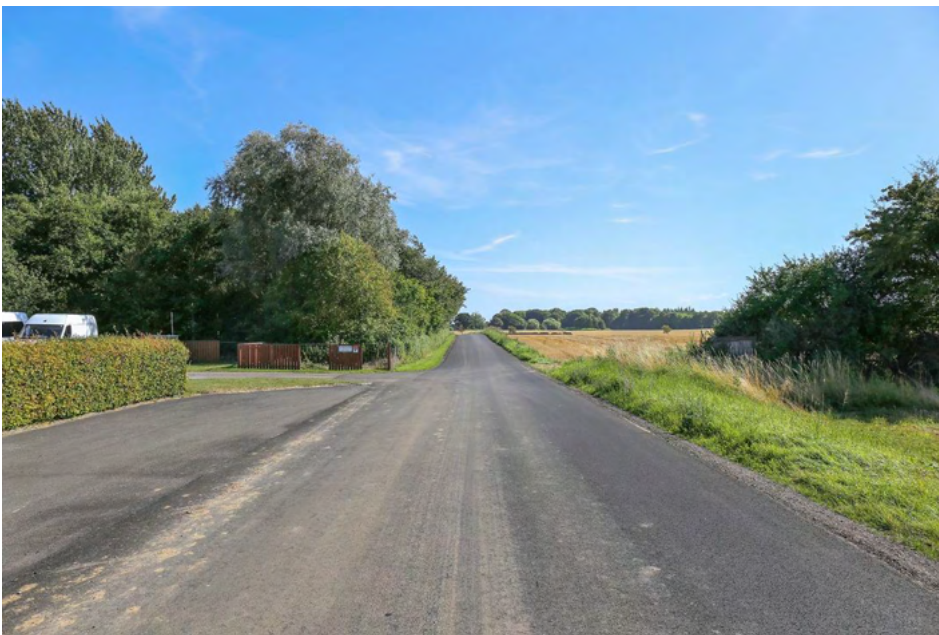
Figur 16-29: Fotostandpunkt 10, eksisterende forhold.
