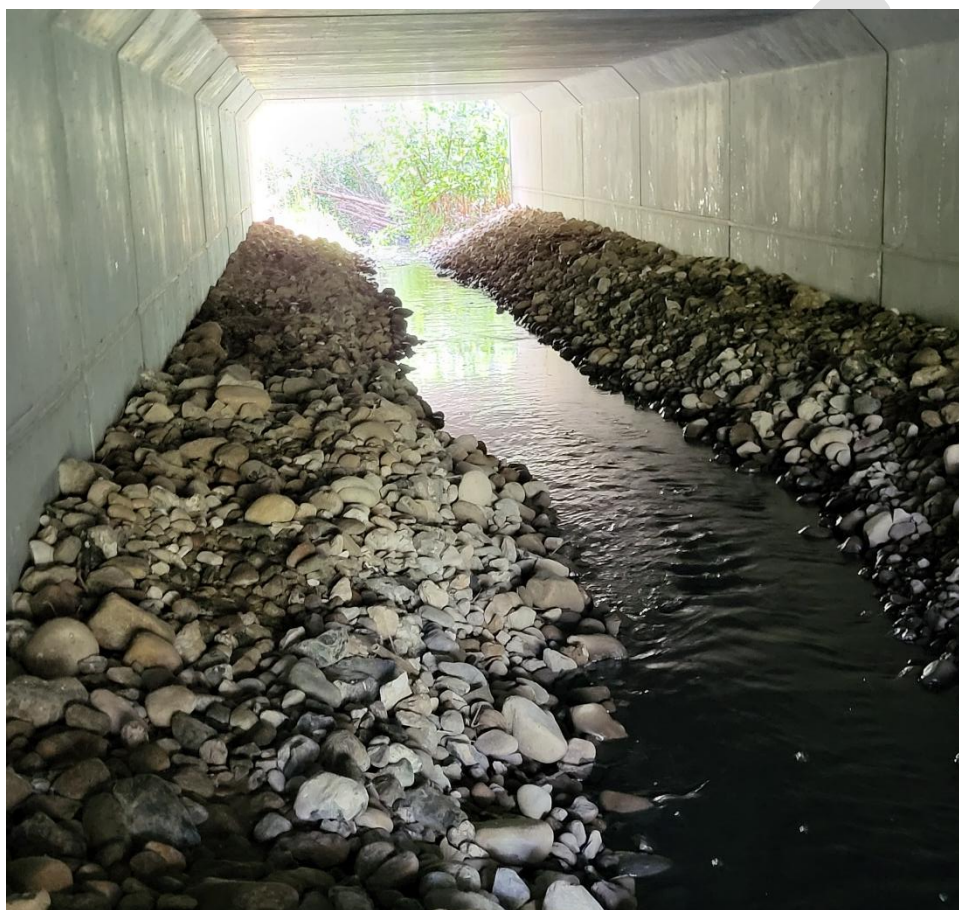
Billede 5.1: Her ses landevejsbor ved st. 600. Broen er anlagt således at vandløbet i fuld brede kan løbe gennem broen.
