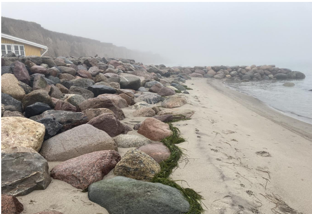
Figur 1.3: Strand, skråningsbeskyttelse og hofde nord for hofden set mod syd. Taget d. 15. februar 2024.
