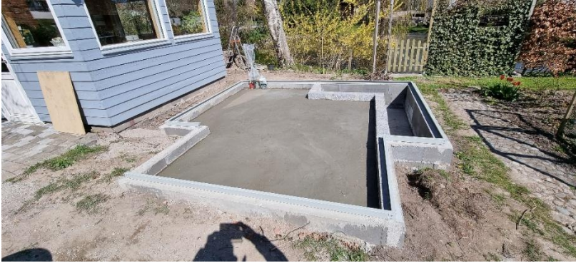
Figur 6: Foto af drivhusets fundament under opførelse af bygningen.
