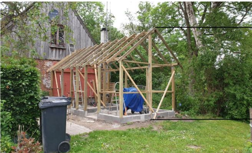
Figur 4: Foto af redskabsskurets hovedkonstruktion. Bygningen er 3,5 m fra sokkel til tagryg.
