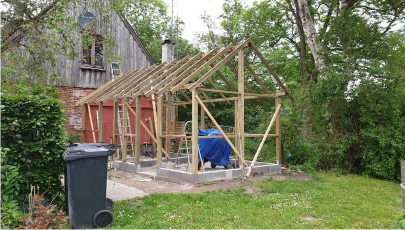
Figur 3: Foto af redskabsskurets hovedkonstruktion under opførelse af bygningen.
