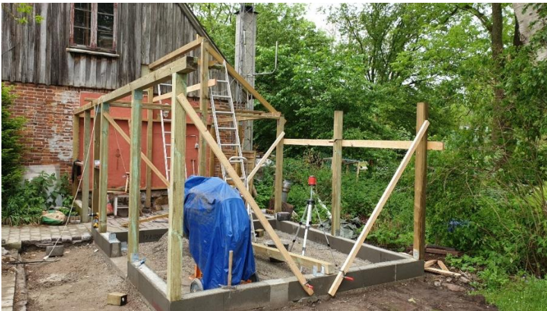
Figur 2: Foto af redskabsskurets bærende hovedkonstruktion under opførelse af bygningen.
