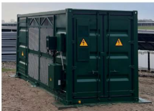
Fotoeksempel af MVS6400-LVcontainer/inverter
