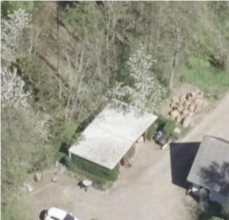
Skråfoto af udhuset Størtingevej 50, 4733 Tappernøje set mod nord på skråfoto fra den 27. april 2025.
