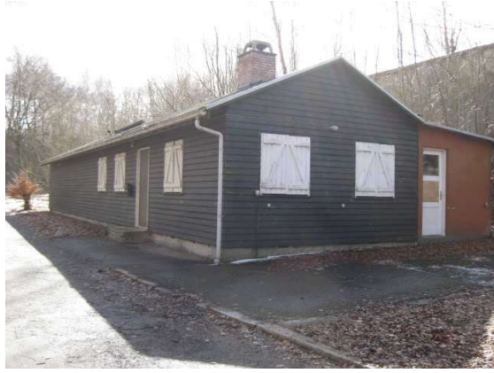
8) Oprindelig skivedepot med værksted
