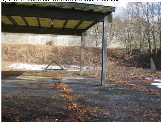
3) Minipanserbane med befæstet areal og jordvolde, set fra øst mod vest
