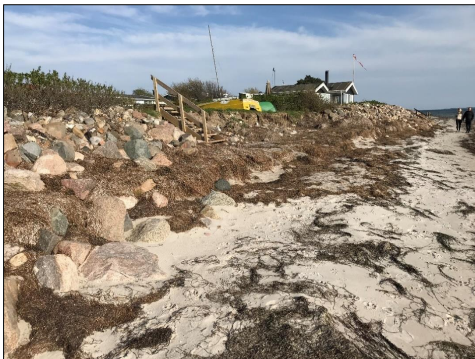
Figur 1.16: Beskadiget kystbeskyttelse og lokalt erosionskår ud for grunden lige sydøst for Strandvej 24 (ved de to både).
