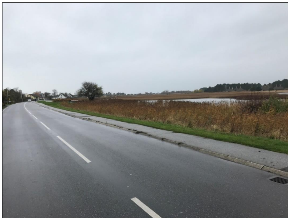
Figur 1.10: Enø Kystvej ud for nr. 114 med orientering mod vest. Ud for træet slutter eksisterende dige.
