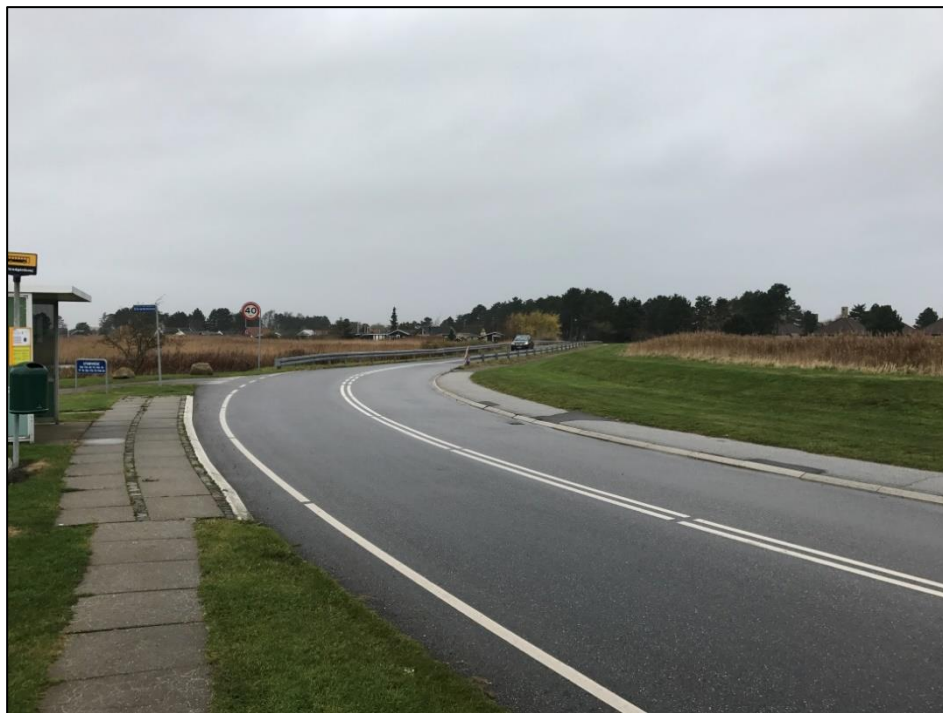
Figur 1.9: Enø Kystvej lige efter dæmning ved Gerbredgårdsvej. Billedet er taget mod nordvest.
