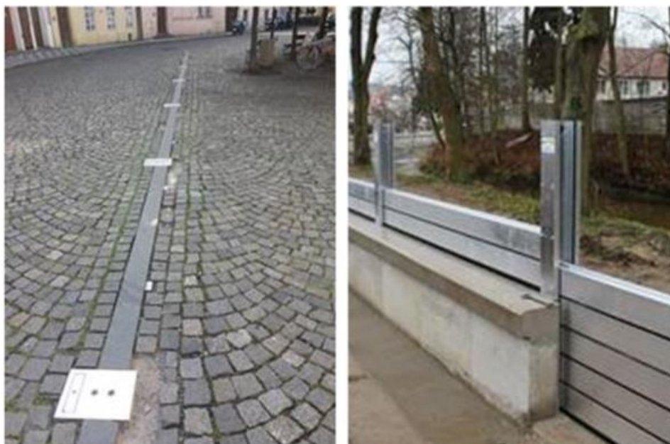
Figur 1.4: Mobile svinerygsplanker i vestligste del af Køge Havn. Tracé med platforme for H-profiler placeres og ved varsel om stormflod opsættes vertikale H-profiler og mellem dem horisontale svinerygsplanker. Kilde: Wintec
