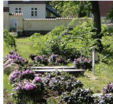
2 x Venus 40 installeret ved skole i Danmark til 80 PE
