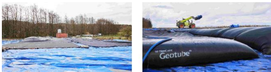
Figur 4. Geobags før og under brug i et tilsvarende projekt – fra ansøgningsmaterialet.
