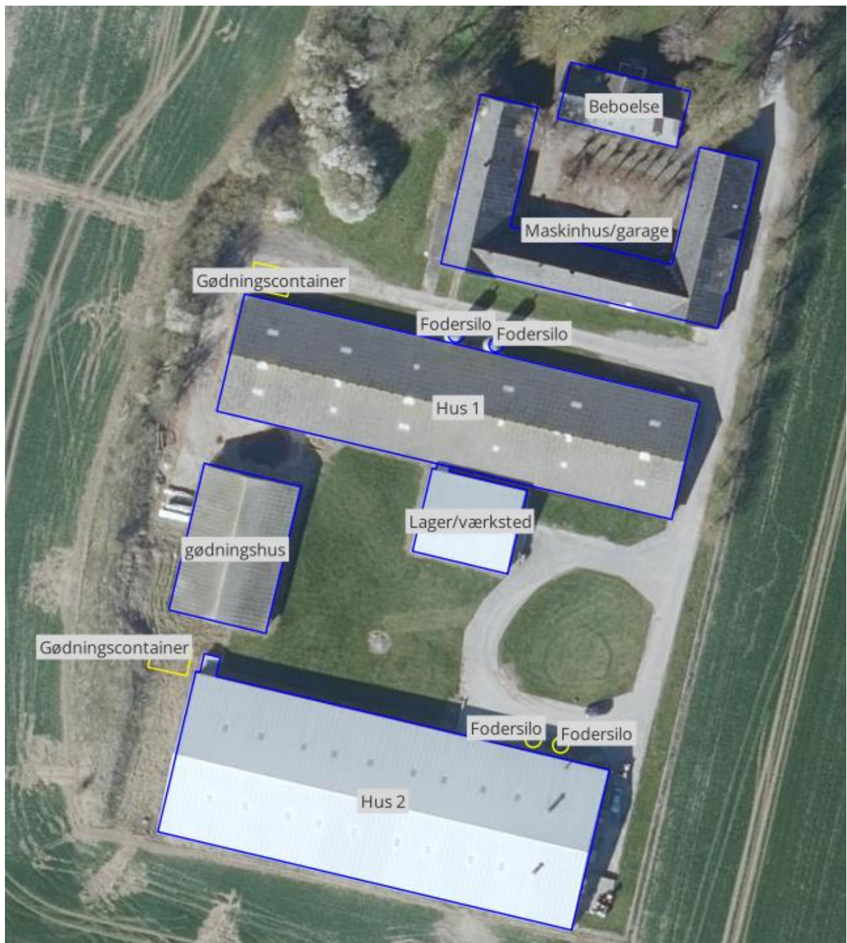
Figur 1 Staldafsnit og opbevaringsanlæg på Hjelmøllevej 6
