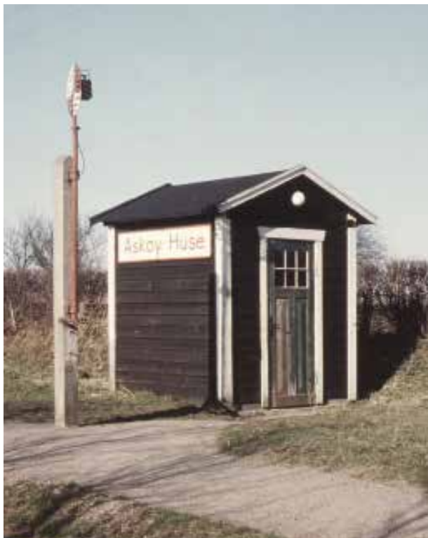
Trinbræt i Askov Huse før nedtagningen
