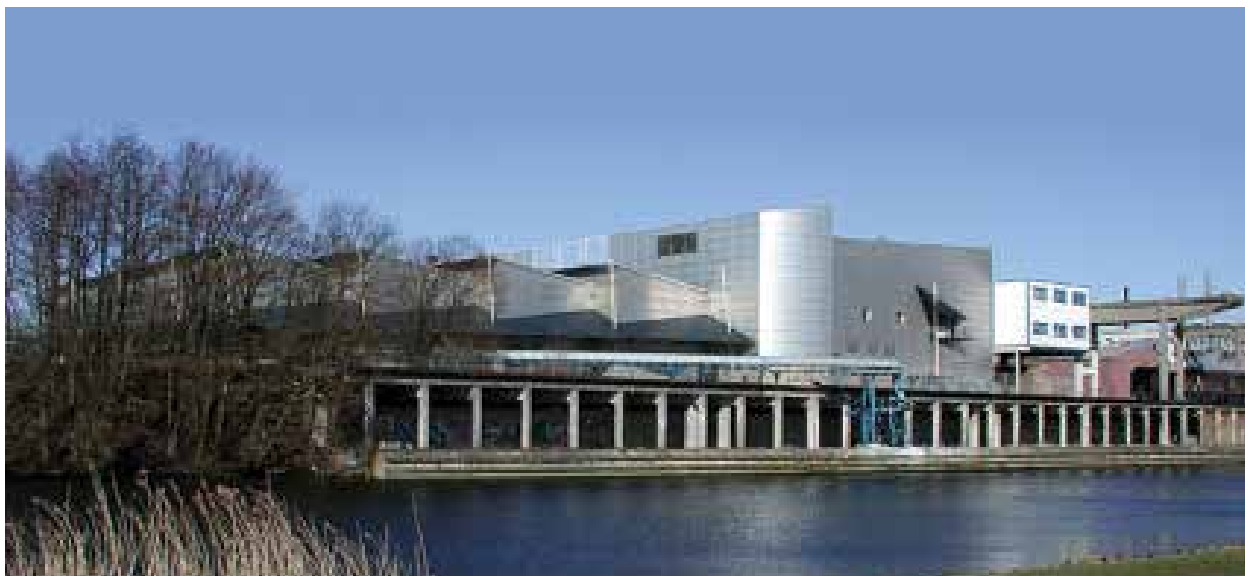
Ny Maglemølle, afsvævningsanlægget
