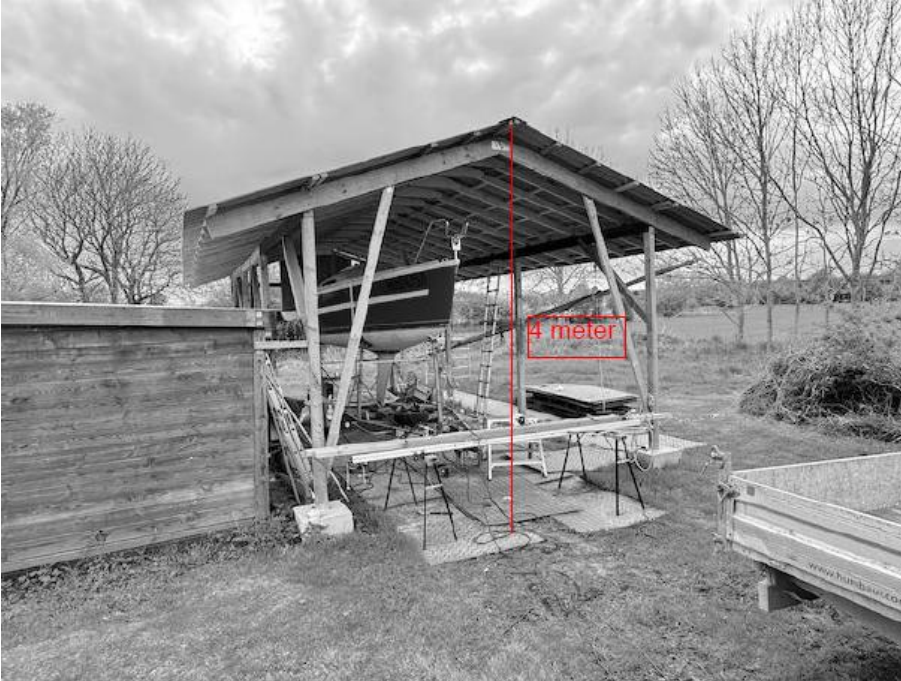
Foto af bådhuset set fra nordøst. Fra ansøgningsmaterialet.
