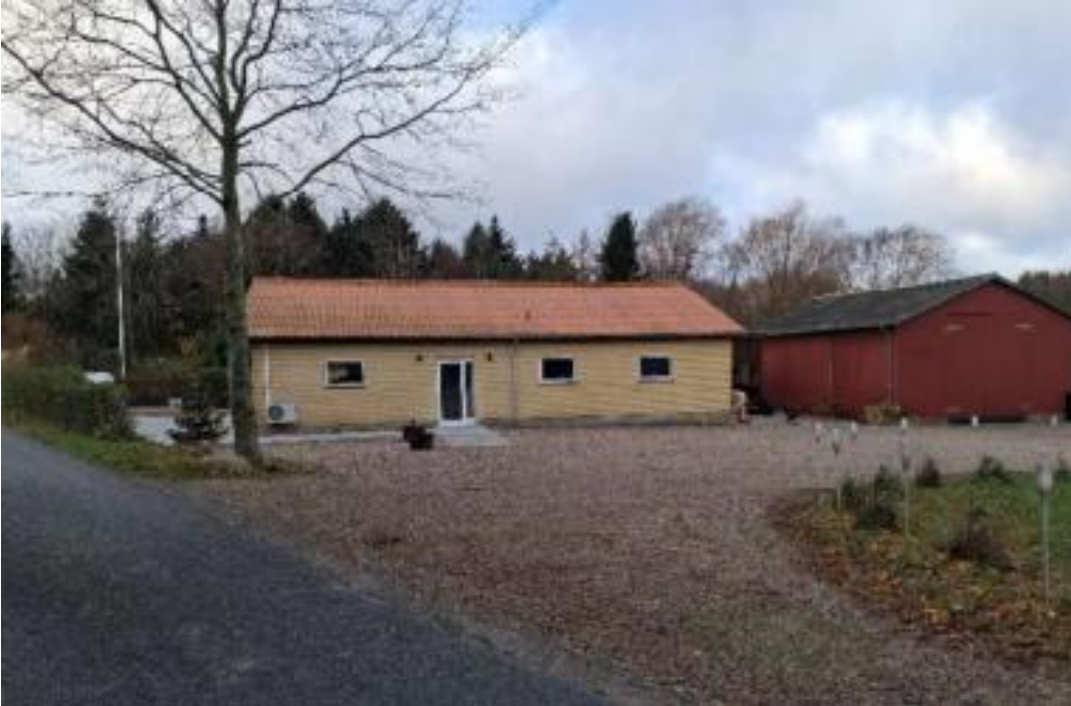
Indkørsel og parkeringsareal ved indgangen til caféen, øst for bygningen med gårdbutik og vineri på Ørebjergvej 6. Foto fra ansøgningsmaterialet.
