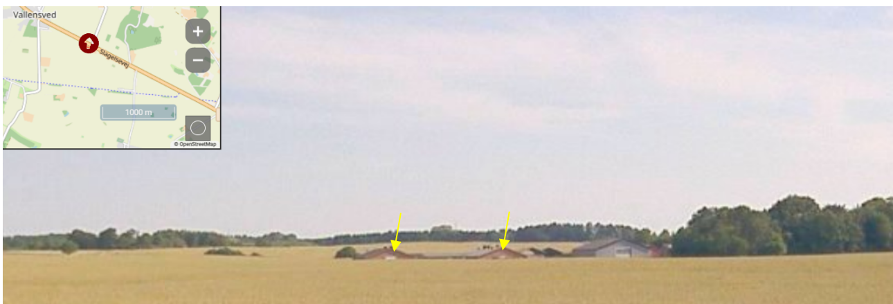
COWI gadefoto set direkte fra syd, 27.6.5.2024: Set fra Slagelsevej. Zoomet. De hvide porte i den eksisterende stalds gavl ses svagt på grund af afgrøde på marken. Pile viser porte i gavlen.
