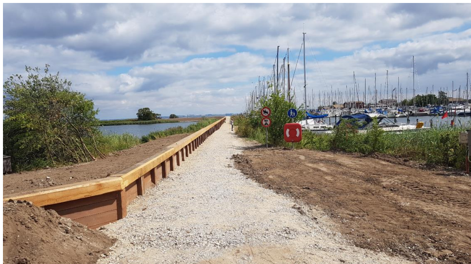
Figur 1.3: Eksempel på højvandsmur i Nivå udført som københavnerveg i azobé (stolper og flager) med topafdækning i lærk.
