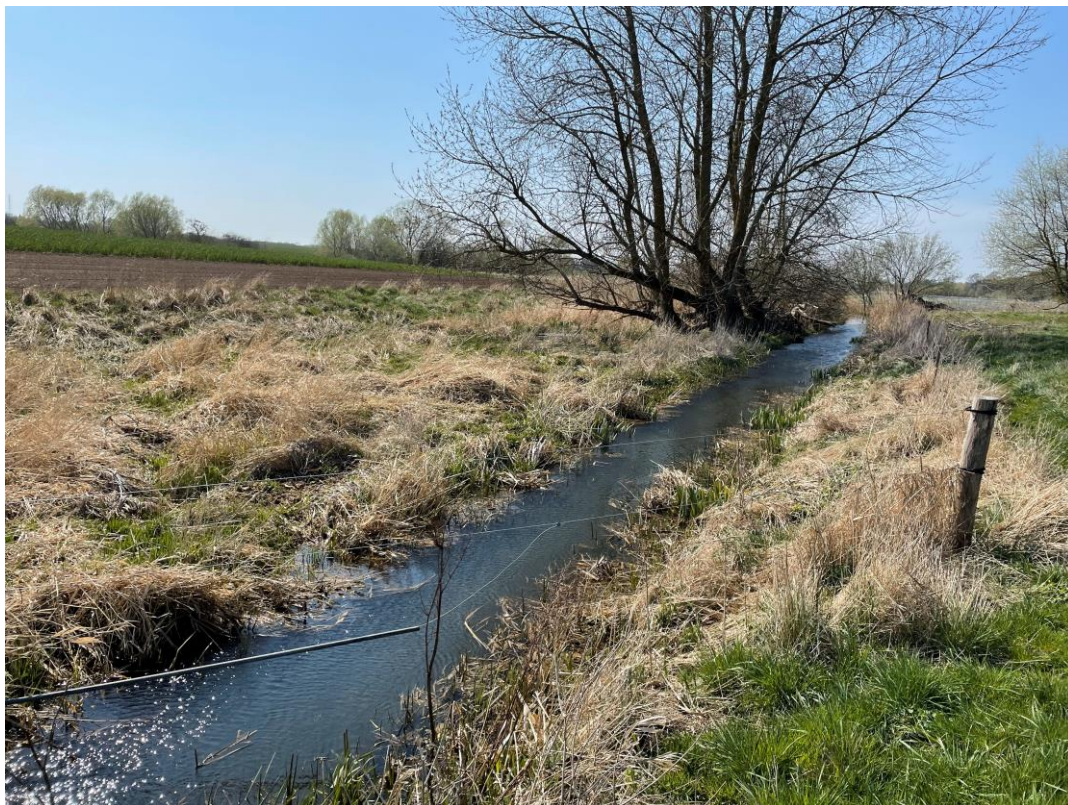
Foto 1: Longsgroft fra st. 1400 og nedstrøms. Dobbeltprofilet kan anes mod højre (nordsiden). På sydsiden ses den ca. 10 m brede bræmme bevokset med primært tagrør og andre græsser.
